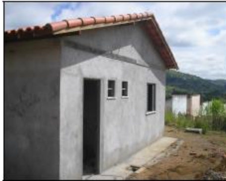
Figura 4 – Residência construída de pré-moldados de bambu.
